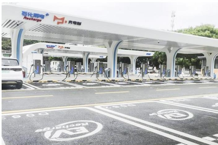
厦门文屏路光储充检超级充电站位于思明区文屏路文屏新能园内（中石化森美文屏加油站旁），占地面积 2817.6 m<sup>2</sup>，周边比邻大型住宅小区、公园景区、购物中心等，车流量大，充电及电池检测等潜在需求较多。为匹配充电需求，该站点配置了 64 台 1000V 180kW-360kW 的直流快充桩，不仅可实现 1000V 高压快充，同时还可以根据车辆的充电需要，柔性分配每根充电枪的最大充电功率，在符合充电桩和车辆电池技术适配的前提下，轻松实现七八分钟补充续航 200km，普通车辆也可在半小时充到 80% 的电量。
