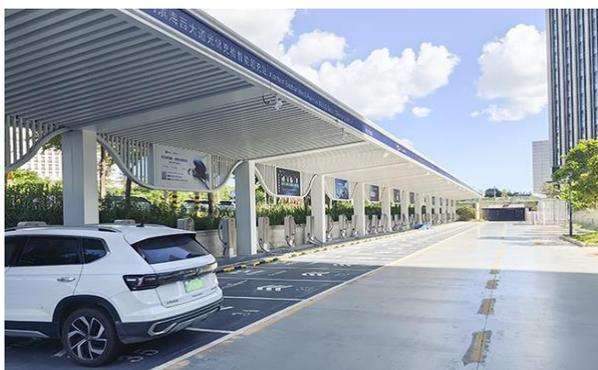
厦门滨海西大道光储充检超级充电站位于厦门滨海西大道 2555 号（美峰创客科技园区 5 号楼 6 号楼之间停车场），占地面积 1116 m<sup>2</sup>，周边毗邻多个住宅小区、商业购物中心、酒店会议中心、科创园区、滨海景区，车流量巨大，新能源汽车充电、车辆电池检测需求旺盛。该站点配置了 36 台 1000V 180kW 的直流快充桩，不仅可实现 1000V 高压快充，同时还可以根据车辆的需要柔性分配功率，在符合充电桩和车辆电池技术适配的前提下，轻松实现七八分钟补充续航 200km，普通车辆也可在半小时充到 80% 的电量。
