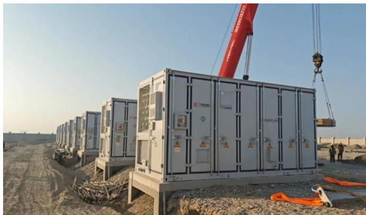
该项目结合各方优势资源，基于卫蓝新能源生产的 280Ah 混合固液电池，采用新源智储 Power Cabin 液冷储能技术方案。在新源智储的技术方案优势下，可有效提升储能系统的高耐寒性及温度精确控制性，充分发挥混合固液电池能量密度高、高安全性、长寿、环保等诸多特点，有效解决当地的新能源消纳，电网调频调压等问题。
